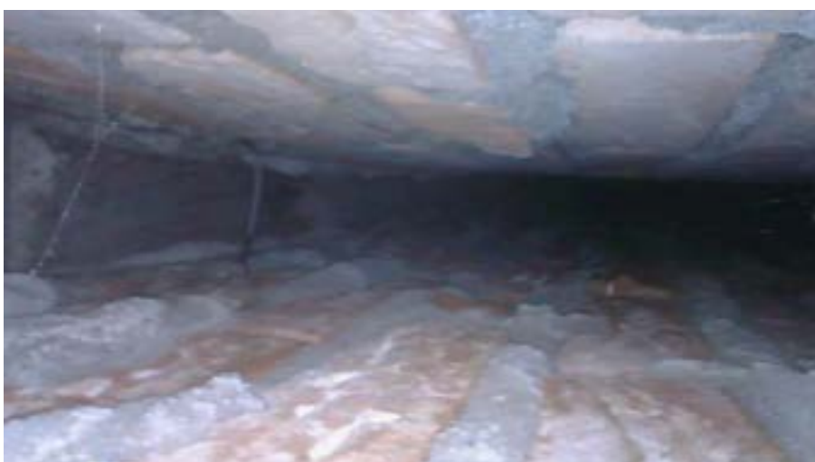
Figuur 5: Opname met een spouwendoscoop van een spouw. Bakstenen zijn 20 cm lang en er zijn tenminste 2 rijen bakstenen te zien, zodat tenminste 50 cm ver gekeken kan worden in een spouw. Opname Peter Twisk.
