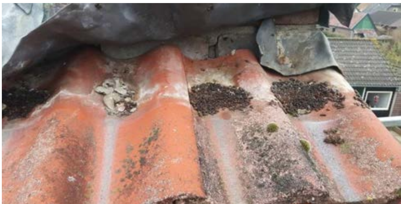
Figuur 3. Bij een inspectie wordt onder andere de ruimte onder loodslabben gecontroleerd. Foto Wim van den Heuvel.*
