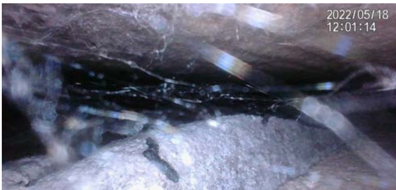
Figuur 6: Uitwerpselen van een vleermuis in een spouw, vastgesteld met behulp van een spouwendoscoop. Opname: Peter Twisk.
